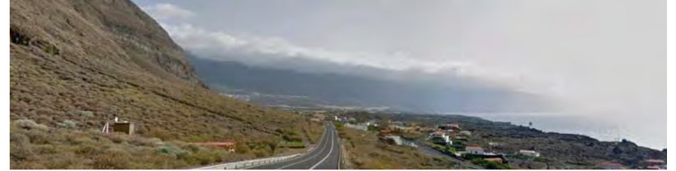
HI-5, salida del túnel en dirección al municipio de La Frontera
