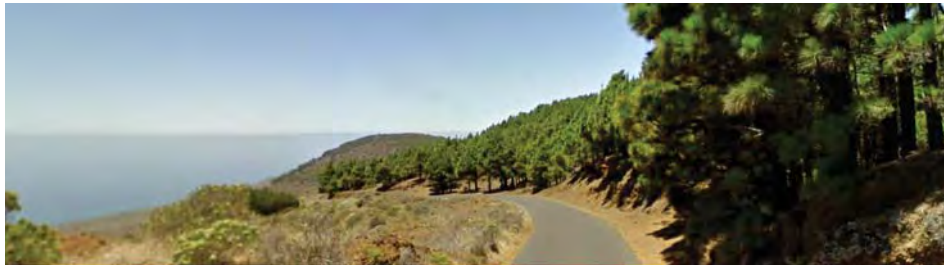
Tramo de la HI-400
