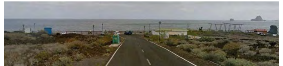
HI-561, en su llegada a la bolsa de aparcamientos de la piscina natural de La Maceta
