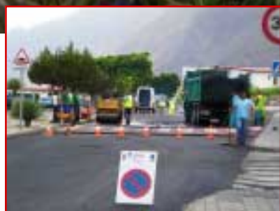
Asfaltado de Las Ramblas
